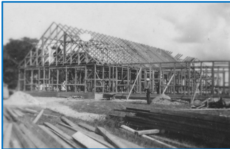
En barak under opførelse
